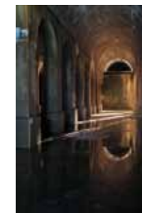
SATURIAS Depósito de agua de Roces I, Gijón
