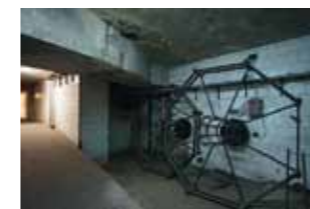
RIATUSAS Zona de calderas, La Laboral, Gijón
