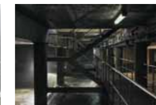
SUARISTA Aliviadero Natahoyo, Gijón
